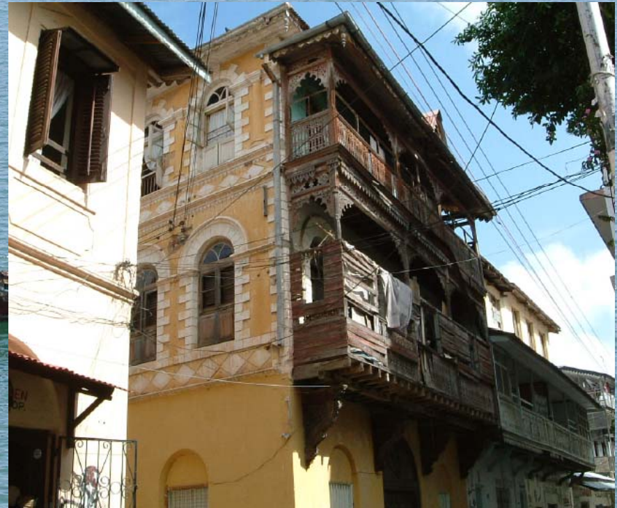
BALCONY ON NDIA KUU ROAD
