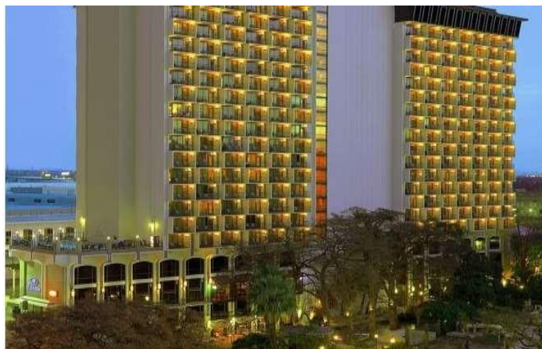
Figure 2.1. Hilton Palacio Del Rio Hotel (Velamati, 2012), USA, Texas.
